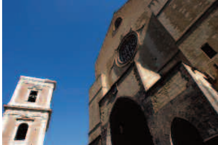
Facciata e campanile
